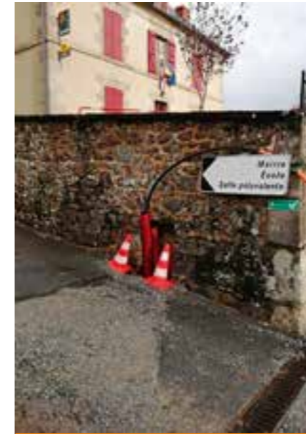
Enfouissement des lignes
